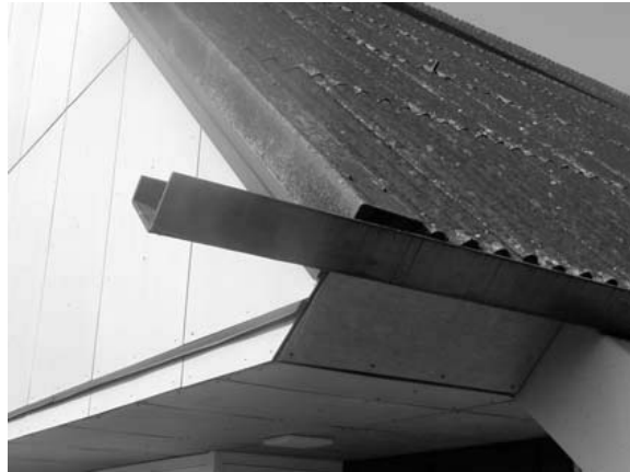
Asbestzement-Wellplatten, Foto IST
