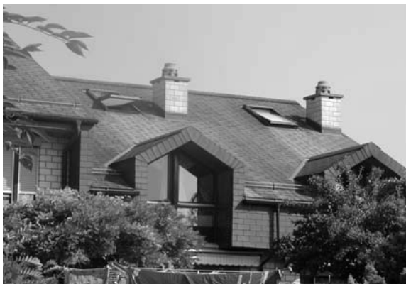
Dachschiefer aus Asbestzement, Foto IST
