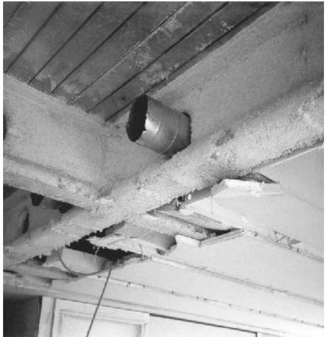
Spritzasbest an einer metallischen Tragkonstruktion, Foto IST
