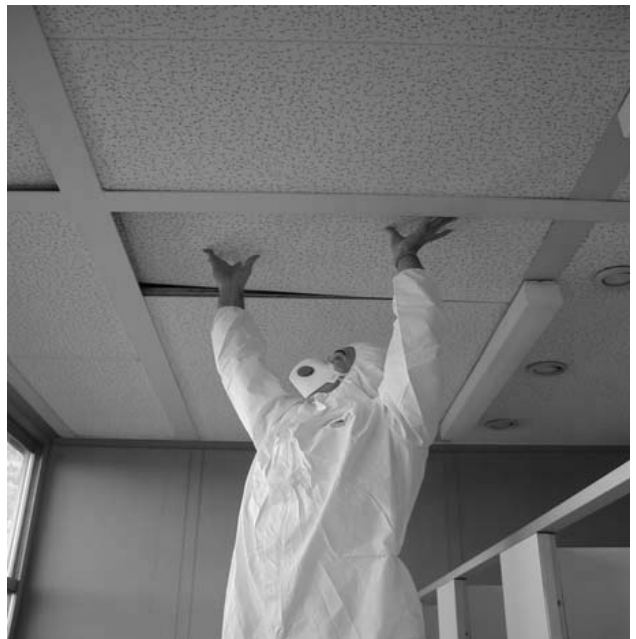
Asbesthaltige, abgehängte Deckenplatte (Akustikplatte), Foto IST
